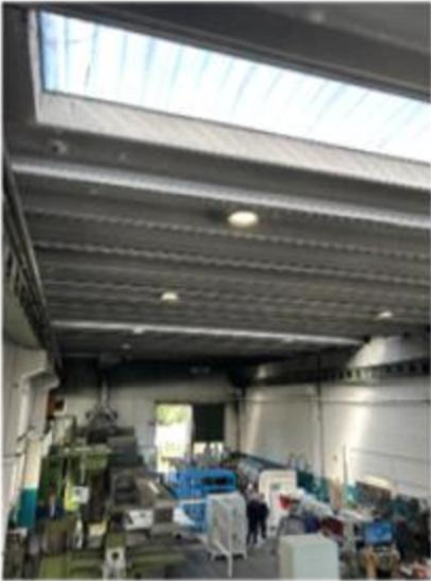
Lucernari e coperture ripristinati a lavori conclusi
